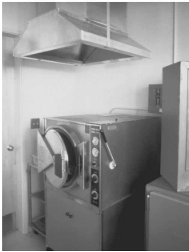
Figura 61.5 • Campana de techo: aspiración en un horno.
